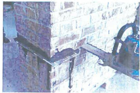
Fig. 2 Motofierastrău cu lanț diamantat
